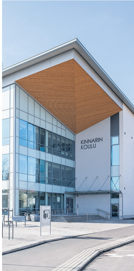
Järvenpäässä sijaitsevan Kinnarin koulun rakennushankkeessa käytettiin Milestone-mallia.
